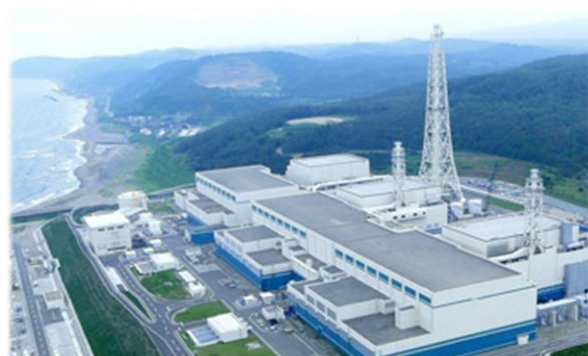
柏崎刈羽原子力発電所
